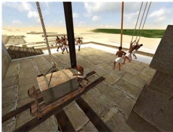
Fig.1. Reconstitution du fonctionnement de levage des blocs de pierre dans l'antiquité égyptienne utilisé dans la construction des pyramides (Dassault Systèmes)
